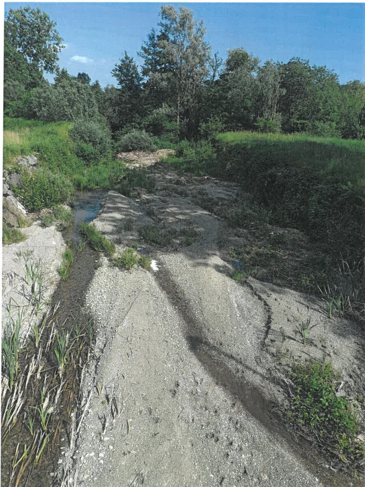
VISTA A VALLE DEL PONTE SULLA S.P. 63 (in fondo confluenza nella Roggia del Mulino)
