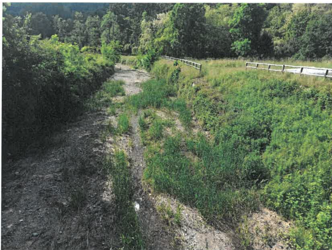
VISTA A MONTE DEL PONTE SU S.P. 63
